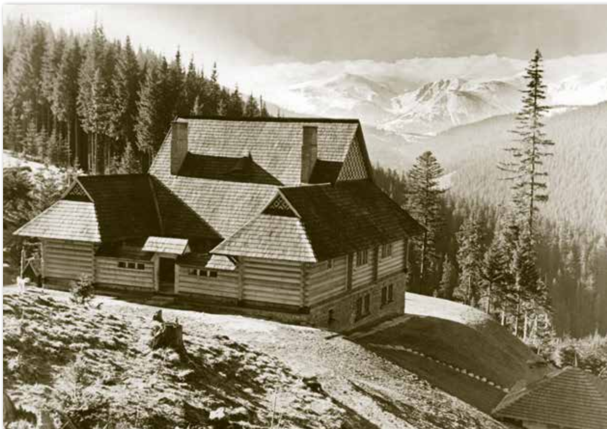
Schronisko na Kostrzycy. W lewym rogu buda dla psa. Na prawo, w dole, budynek agregatu prądowłórczego. Zbiory: Narodowe Archiwum Cyfrowe.
