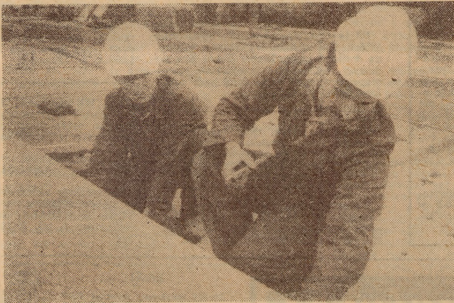
Pracownicy „Termoizolacji” Krzysztof Bernady i Rogdan Jamróg z brygady Jerzego Tomasika wykonują obłachowanie elektrofiltra na EC II.
