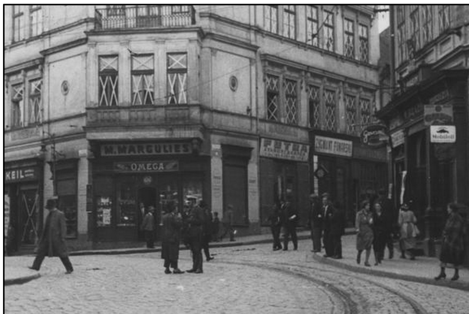
Łuk torowiska tramwajowego pomiędzy pl. Sobieskiego a ul. Wałową.
