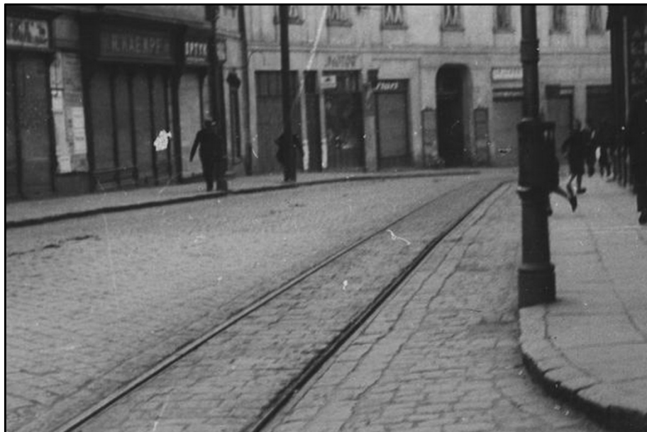
Torowisko tramwajowe w zachodniej części ul. Wałowej.
