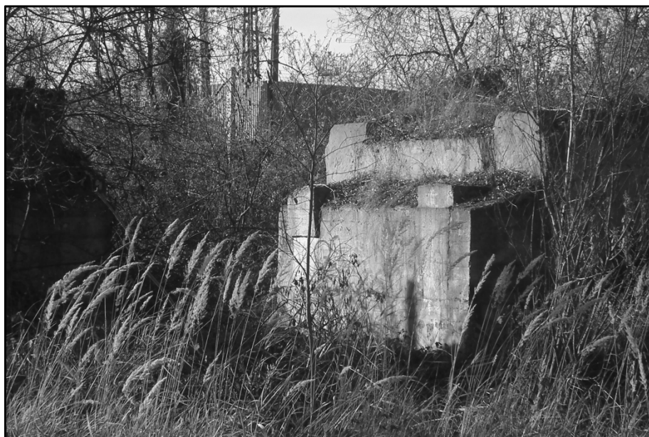
Pozostałości przyczółków wschodnie wiaduktu kolejowego przy cegielni Mieszczanka. Górą przebiegało torowisko normalnotorowe a dołem wąskotorowe. Wiadukt miał prawdopodobnie konstrukcję metalową.
