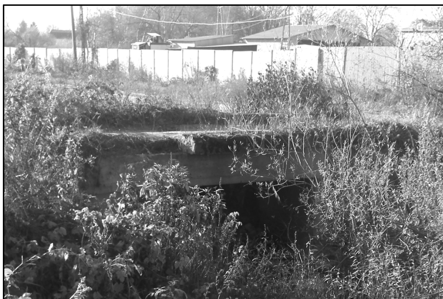
Pozostałości zachodniego wiaduktu kolejowego przy cegielni Mieszczanka. Górą przebiegało torowisko normalnotorowe a dołem wąskotorowe.
