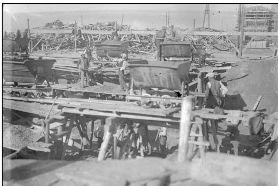
Kolejka wąskotorowa podczas budowy PFZA.
