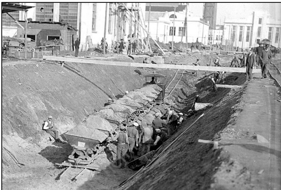
Pociąg wąskotorowy na tymczasowym torowisku podczas budowy Państwowej Fabryki Związków Azotowych w Mościcach.
