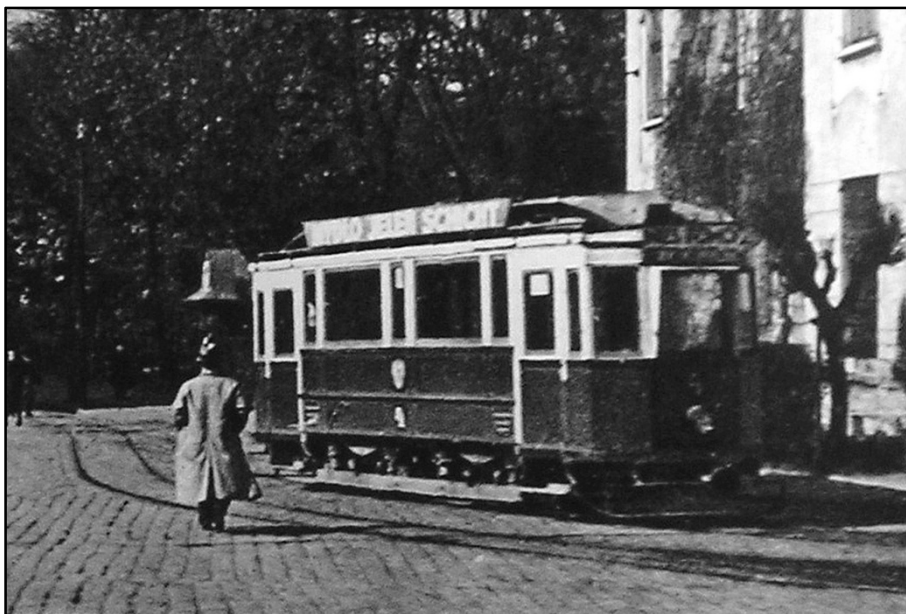
Wóz nr 4 po przebudowie. W górnej części zamontowane są panele z reklamami.
