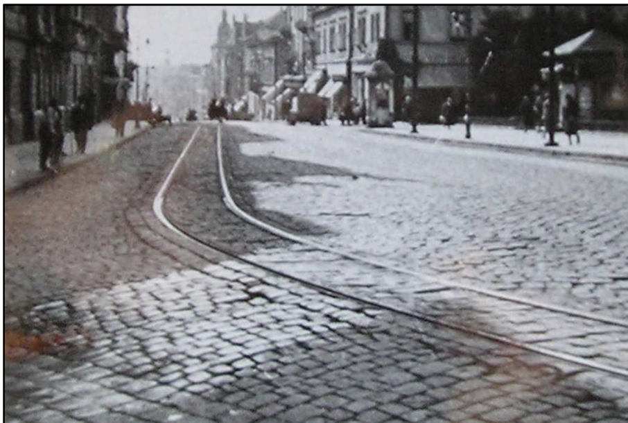
Torowisko tramwajowe na pl.Sobieskiego.
