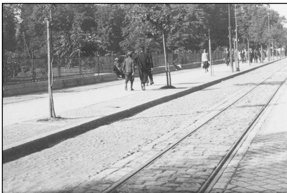
Torowisko tramwajowe na ul. Krakowskiej na wysokości Plant
