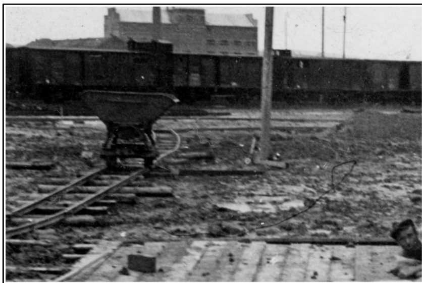
Wagon i torowisko wąskotorowe podczas budowy nowej parowozowni w czasie II wojny światowej na terenie Tarnowa.
