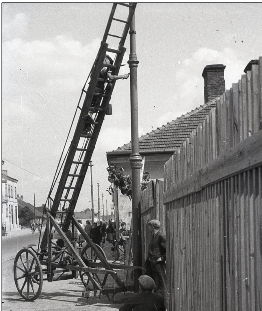
Malowanie słupa trakcyjnego.
