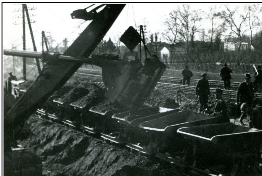
Wagony wąskotorowe wykorzystywane przy pracach ziemnych związanych prawdopodobnie z przebudową torowiska normalnotorowego na terenie Tarnowa. Po lewej stronie widoczna również lokomotywa wąskotorowa.
