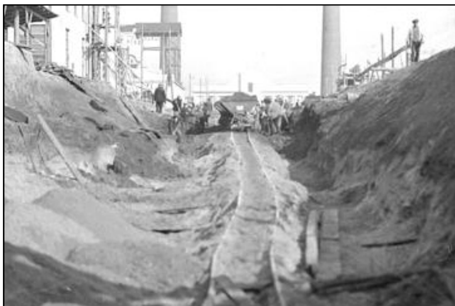
Kolejka wąskotorowa podczas budowy PFZA.
