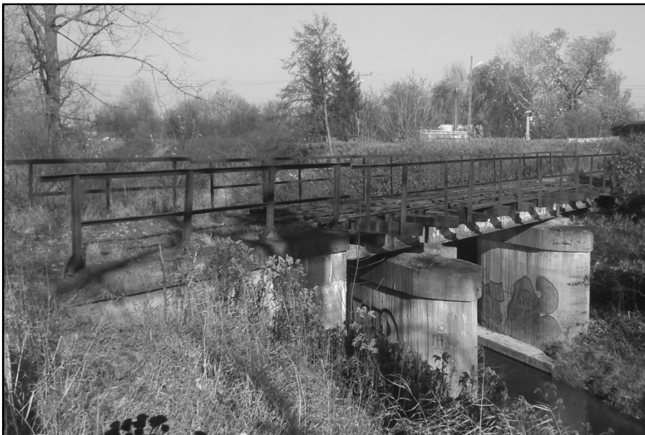
Most nad sztucznym korytem potoku Wątok na którym znajdował się splot toru wąskotorowego i 1 453 mm. Stan współczesny.
