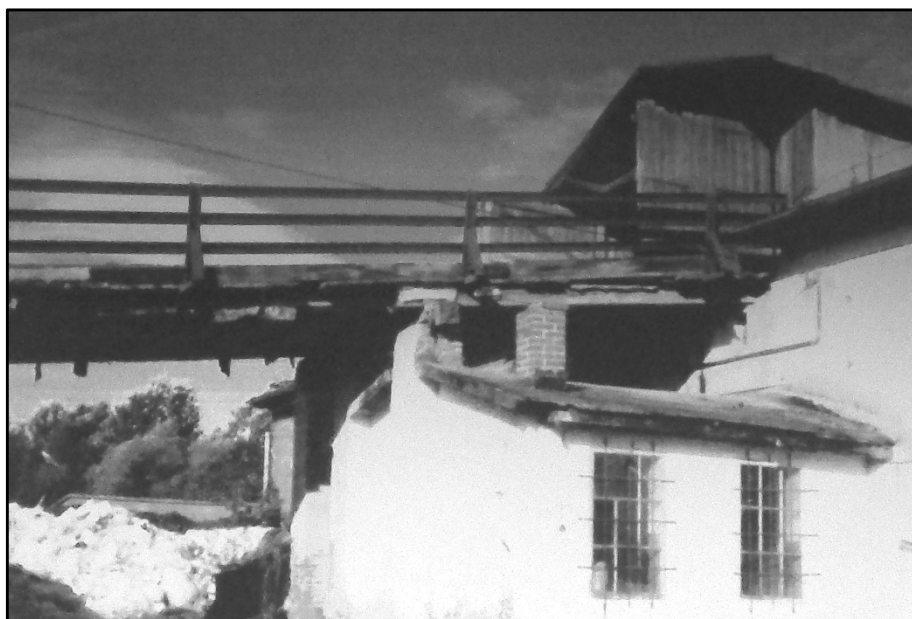
Pochylania cegielni Mieszczanka z torowiskiem, po którym wciągano wagoniki wąskotorowe.
