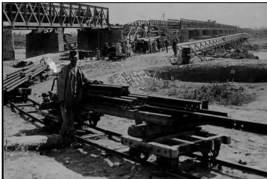
Wojskowa kolejka wąskotorowa w czasie I wojny światowej wykorzystywana podczas odbudowy mostu.
