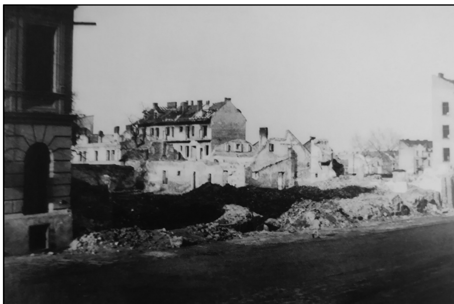
Ul. Lwowska na wysokości obecnego pl. Ofiar Stalinizmu. Widoczne zniszczenia powstałe w okresie II wojny światowej. W prawej, dolnej części fotografii słabo widoczne nieczynne już torowisko tramwajowej.
