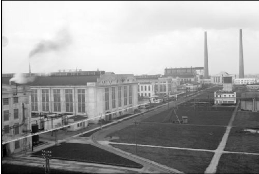
Torowisko wąskotorowe po wschodniej stronie głównego ciągu technologicznego. Na dodatkowej fotografii pociąg z lokomotywą na tym samym odcinku torowiska.
