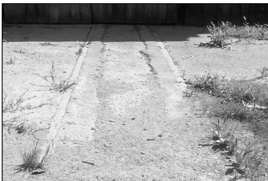
Zachowany fragment torowiska wąskotorowego przed halą w rejonie ul. Fabrycznej
