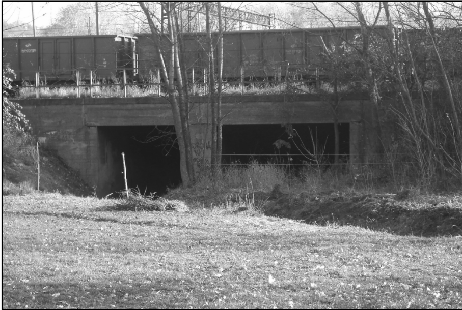
Wlot do tunelu pod stacją Tarnów Filia od strony ul. Grunwaldzkiej. Prawym tunelem poprowadzono była kolejka wąskotorowa, zaś lewym płynął potok Strusinka. Stan współczesny.
