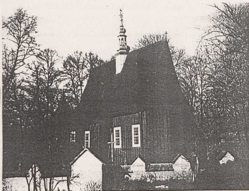
Kościół p.w. Narodzenia NMP z początku XVI w.
