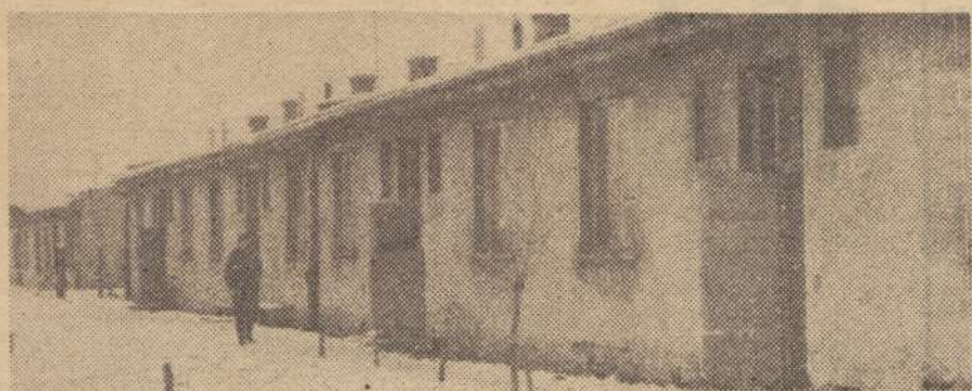
Już ostatni rok służyć będą baraki Kapro za mieszkania naszym pracownikom.
