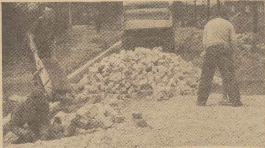
Pracownicy wydziału budowlano — drogowego przy przebudowie ulicy Chemicznej (1965 r.).
