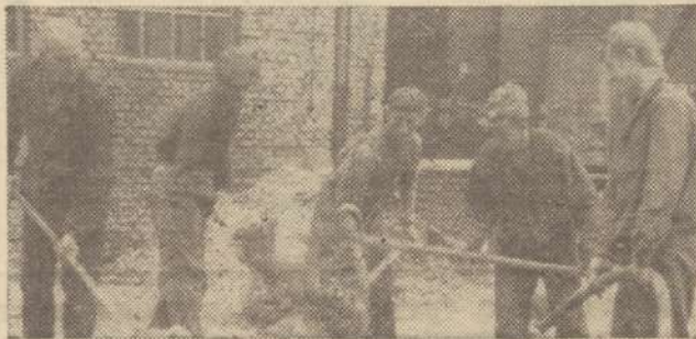
Brygada Cieciergi betonuje plac przed budynkiem K 8/9. fot. J. Iwański
