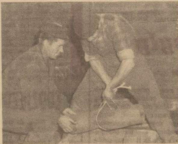
NA ZDJĘCIU: w 50-stop niowym upale formierze przygotowują formy na odlew.
