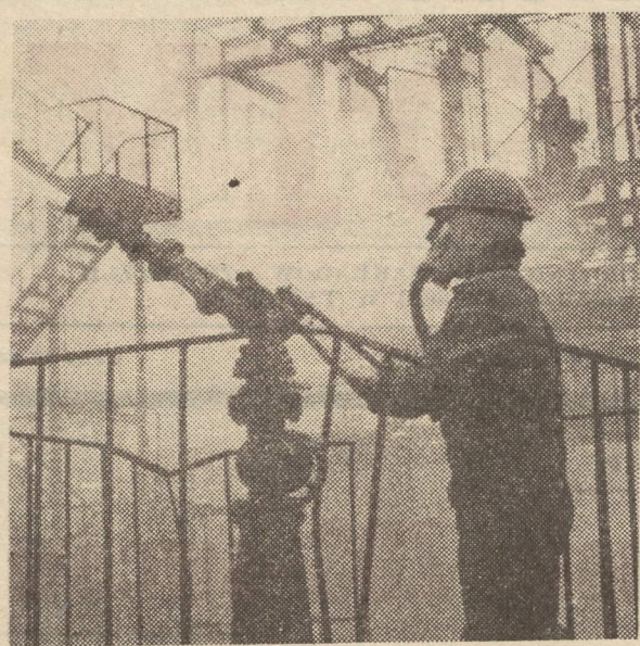
Członek obowiązkowej sekcji gaśniczej ZOS obsługuje armatkę wodną podczas alarmu na instalacji akrylonitrylu.
