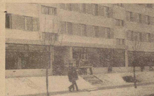
Nowo wybudowany blok mieszkalny na Osiedlu Strusina.
