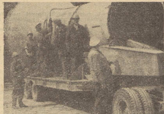
Żaladowany na platformę podczołgową kocioł utylizator, oraz brygada która dokonała jego załadunku. Fot. J. Iwański
