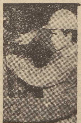
Instalacja akrylonitrylu. Na dolnym zdjęciu Ryszard Wajda przy montażu instalacji.
