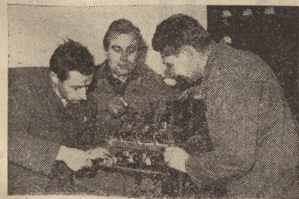
Brygada Henryka Zajacę remontuje aparaturę wyłącznikową.
