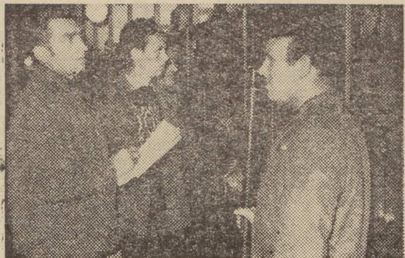
Brygada M. Rajska podczas przełączenia w rozdzielni wysokiego napięcia.
