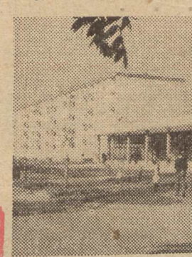
Z roku na rok rośnie i pięknieje osiedle przyzakładowe w Tarnobrzegu — Świerczkowie. Na zdjęciu: fragment osiedla.
