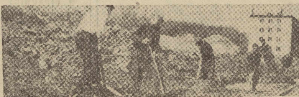
Pracownicy akrylonitrylu w czynie społecznym pracowali przy budowie stadionu lekkoatletycznego.
