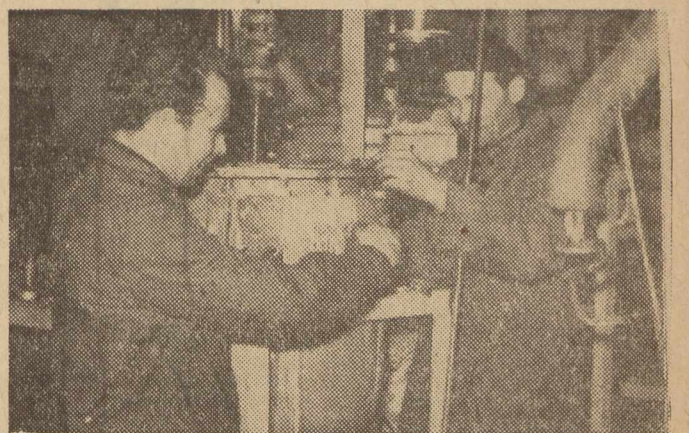
Pracownicy Zakładu Produkcji Doświadczalnej przy montażu aparatury.
