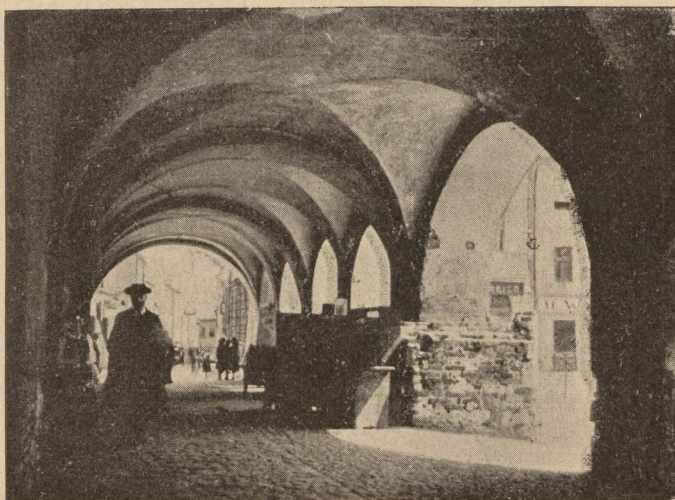
Podcienia w rynku — Arkadenausbauten — Les arcades
