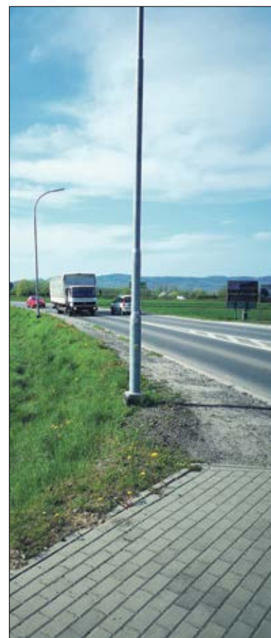
Widoczny na zdjęciu odcinek od ronda do mostu nad Dunajcem otrzyma nowy chodnik pieszo-rowerowy
