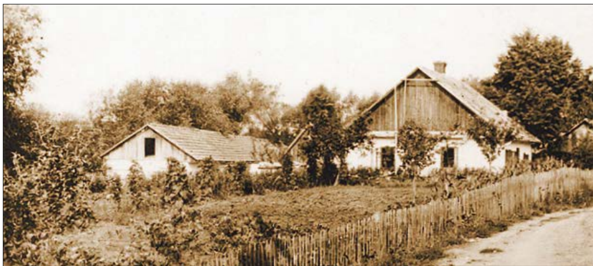
Tzw. „Budzynówka” w Kończyskach widziana od wschodu. Po lewej widoczne stajnie, po prawej dom mieszkalny i w głębi spichlerz. Po stronie południowo-zachodniej stały zabudowania wielkich stodół i wozownia, a pośrodku obszernego podwórza drewnutnia z głębokim loszkiem i studnia
