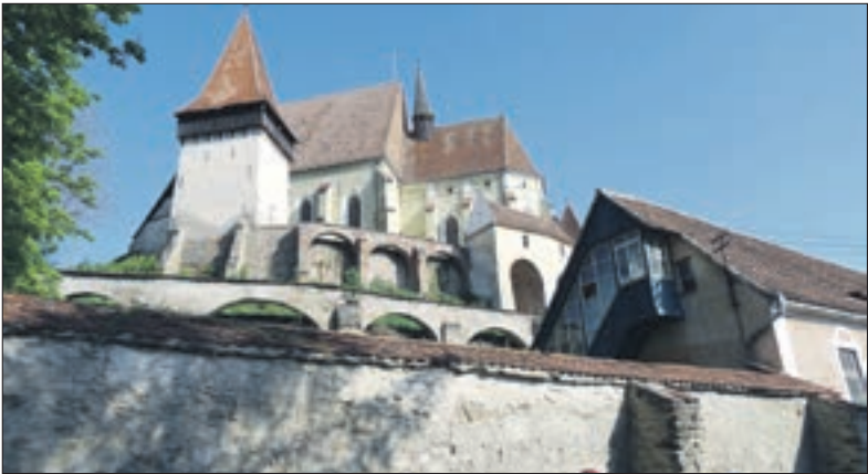
Biertan - widok potrójnych murów
