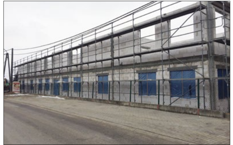
Prace budowlane, gdy sprzyja temperatura, wykonywane są również w okresie zimowym
