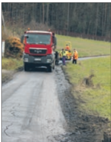
Remont drogi w Olszowej
