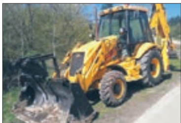
Koparka już pracuje!
