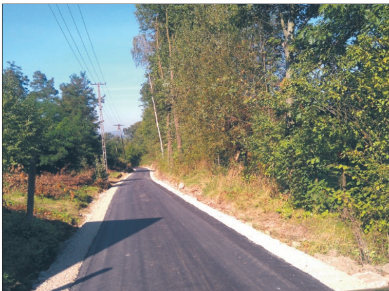
Remont drogi w Stróżach w ramach FOGR
