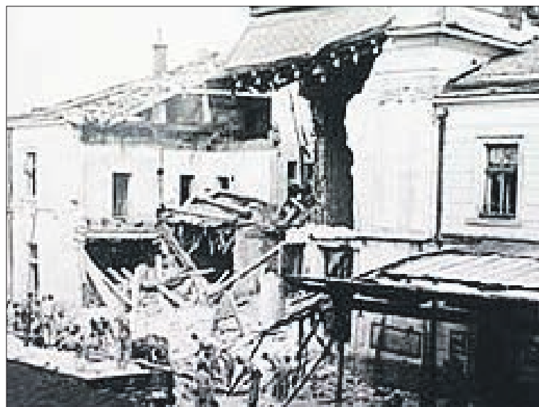
Dworzec kolejowy w Tarnobrzegu uszkodzony podczas wybuchu bomby zegarowej w dniu 28. VIII. 1939 r.
