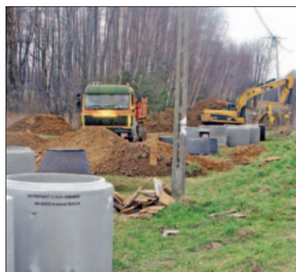
Budowa kanalizacji w Stróżach
