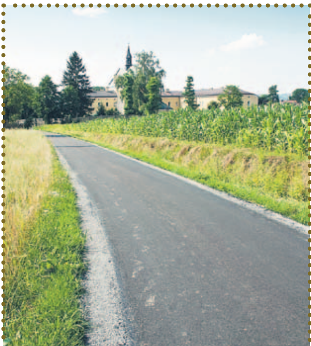
Odbudowa dróg gminnych w ramach usuwania skutków klęsk żywiołowych - Faściszowa
