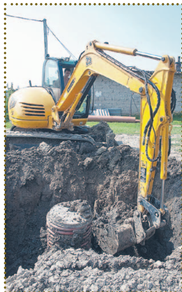
Budowa kanalizacji w Fańciszwowej
