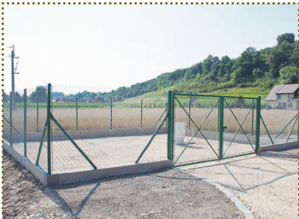
Budowa kanalizacji w Charzewicach
