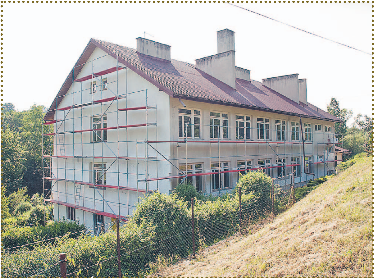
Termomodernizacja budynku szkoły w Gwoźdźcu
