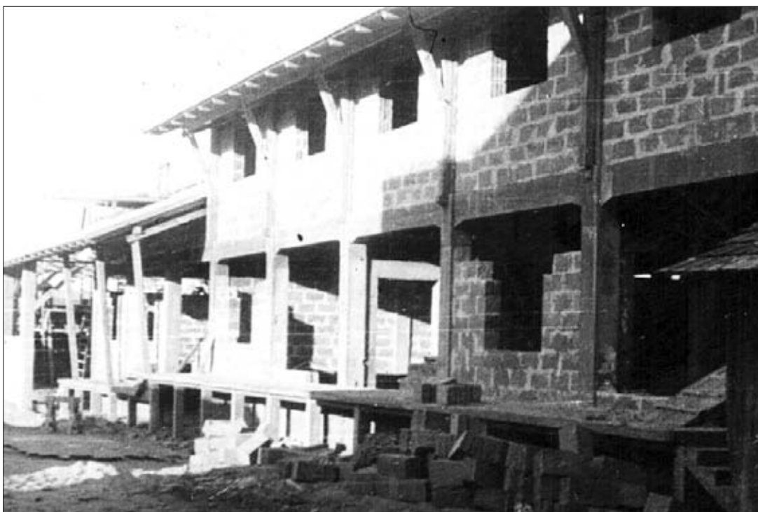
Magazyny spółdzielni Handlowo-rolniczej Snp w trakcie budowy
