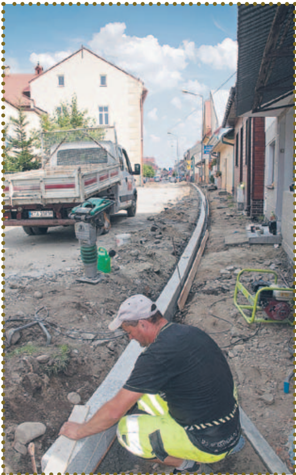
Budowa chodnika - ul. Różana w Zakliczynie
