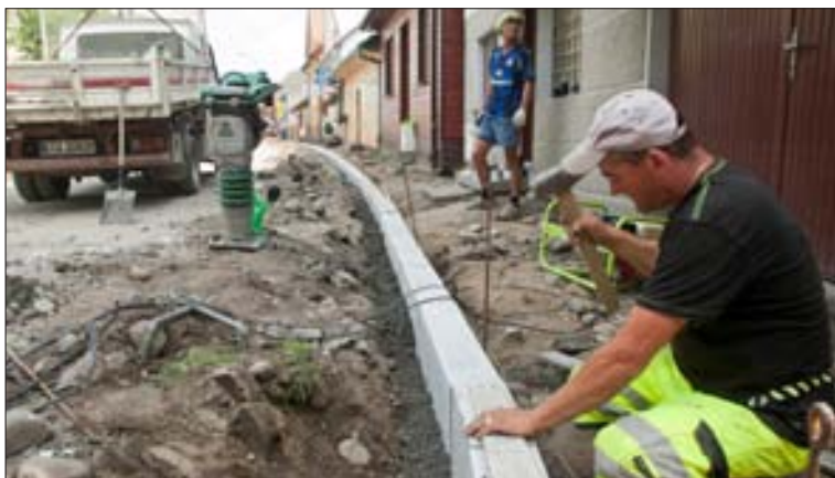
Chodnik na ul. Różanej jest już gotowy
