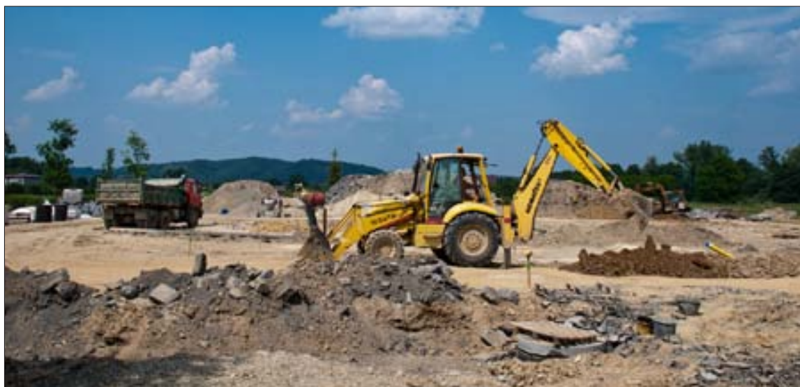
Roboty ziemne w Strefie Aktywności Gospodarczej
