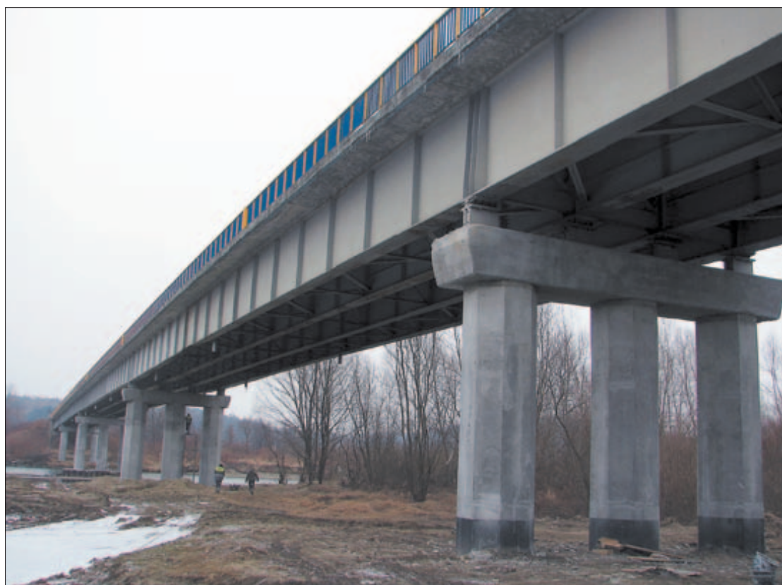
Od kwietnia br. obowiązywać będzie na moście sygnalizacja świetlna
