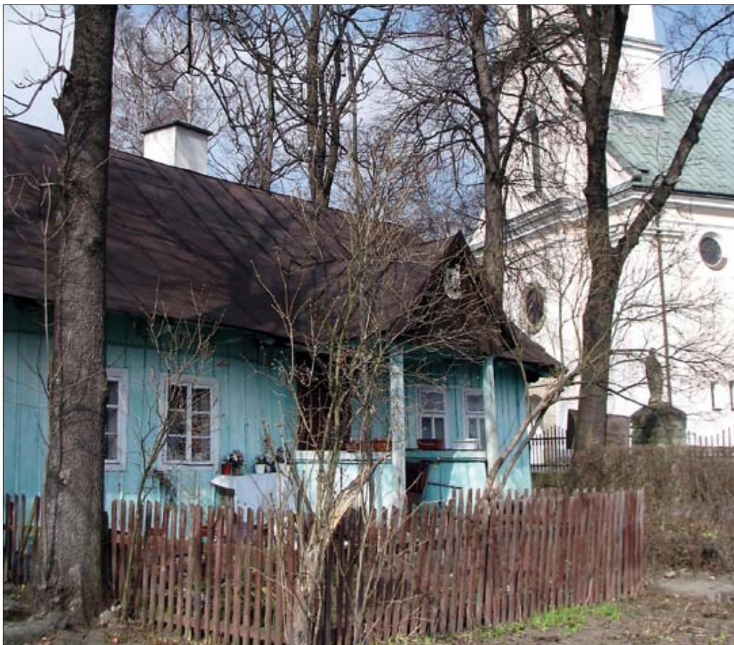
Dom Ubogich nadszarpnięty przez ząb czasu
