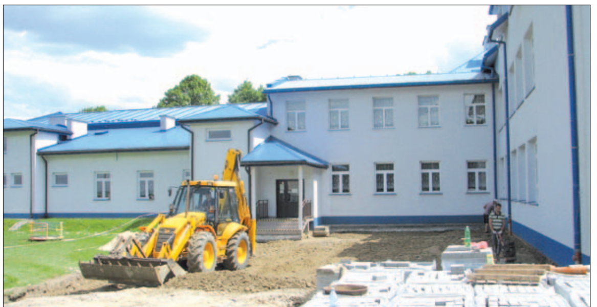
Na nawierzchni placu przyszkolnego w Stróżach położono betonową kostkę
