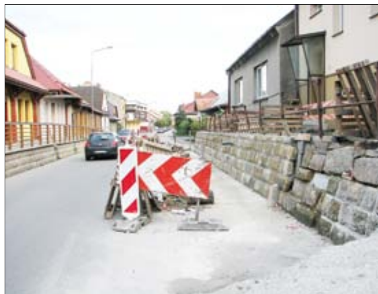
Renowacja drugiej strony wysokiego chodnika na ul. Mickiewicza
