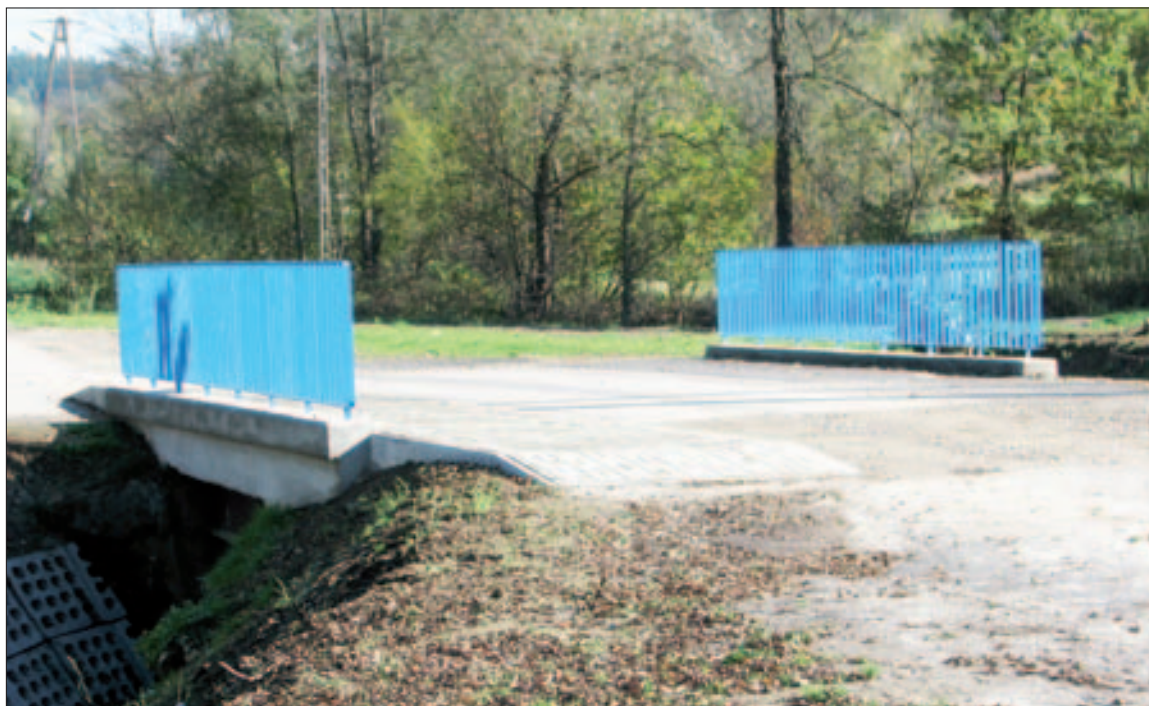
Mostek w Gwoźdźcu przy kościele doczekał się remontu
