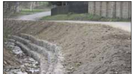
Wzmocnione pobocze objazdu k. Bernardynek w Kończyskach wykonał „Mel-Dróg” z Zakliczyna
