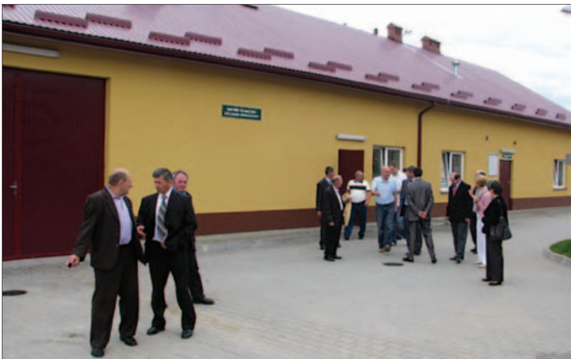
Obiekt oczyszczalni - na zewnątrz i wewnątrz - robi wrażenie. W środku nowoczesne urządzenia, sanitariaty, szatnie, biura i wolne pomieszczenia, część z nich do potencjalnego wykorzystania
