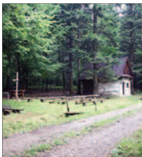
Budka przed remontem z oddali
