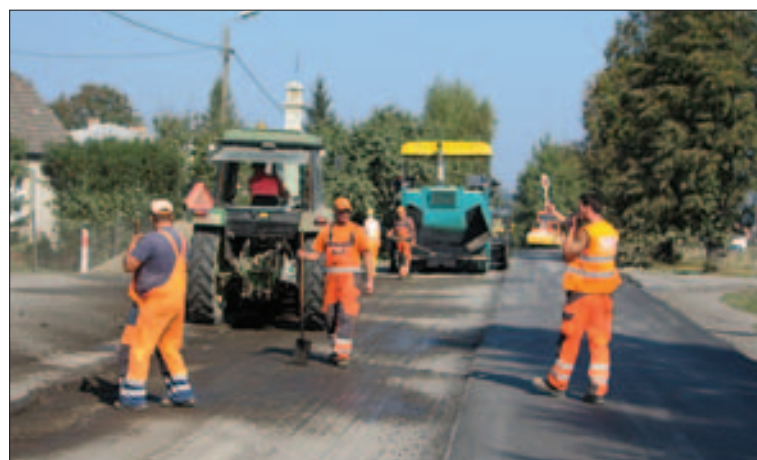
Skrzyżowanie na ul. Ruchu Oporu i Sobieskiego jest gotowe do użytku, druga zebra dla pieszych powstała przy ul. Jagiellońskiej, tamże budowany jest nowy chodnik na „starej” jezdni
