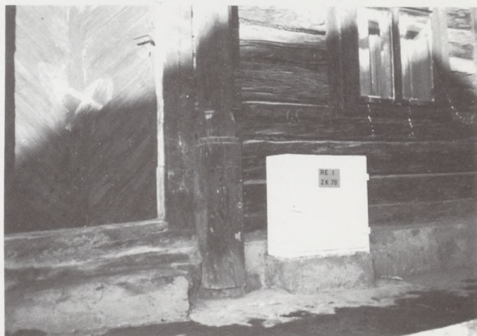
Przy zabytkowych domach nowoczesne skrzynki elektryczne wcale nie zdołają.
