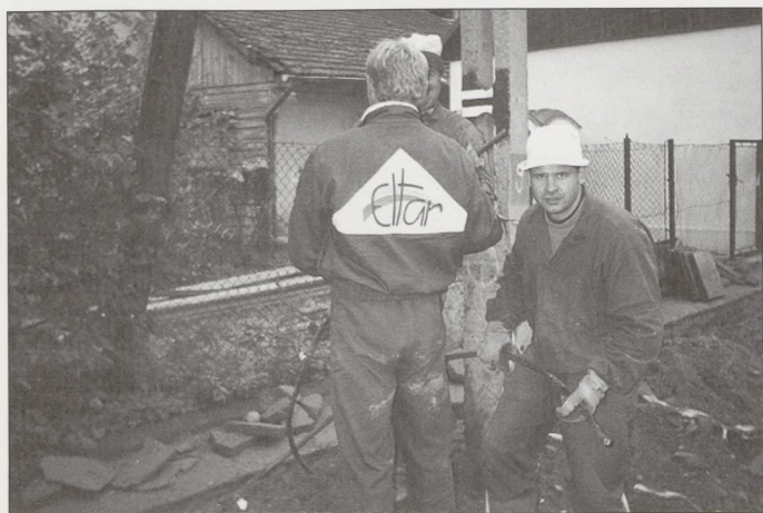
Firma „Eltar” pracuje już przy kablowaniu na ul. Jagiellońskiej.
