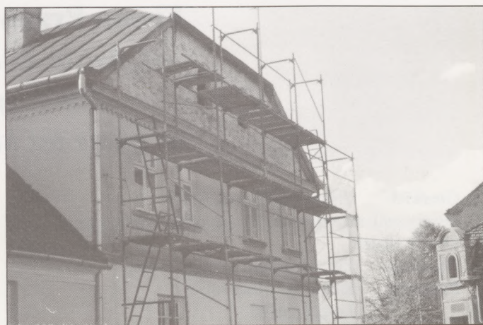
W maju trwały wykończeniowe prace przy budynku mienia wsi i zostały ukończone. Cieszymy się z tego powodu, gdyż budynek leży w strategicznym punkcie Zakliczyna, a sezon turystyczny tuż tuż.
