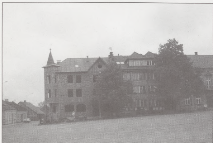
To okazały widok ukończonego już stanu surowego II części budynku Urzędu Gminy.
