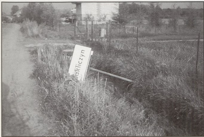
1. Tym razem padła Tablica informacyjna przy wjeździe do Zakliczyna od strony Wesołowa.
