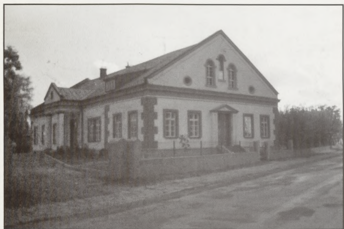
Teraz całkiem okazałe wygląda plebania w Zakliczynie. Po przeprowadzeniu przez ks. proboszcza remontów wewnętrznych i elewacji zewnętrznej budynek prezentuje się zupełnie inaczej.
