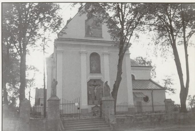
Po odnowieniu elewacji dziś trwają końcowe prace przy układaniu kostki wokół kościoła parafialnego w Zakliczynie.
