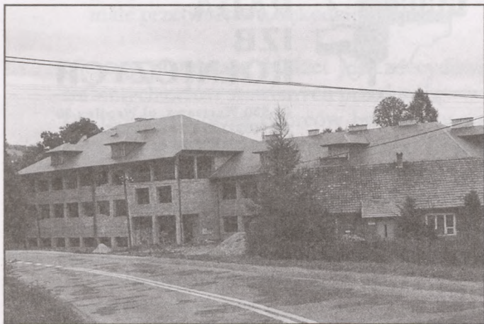
W 1998 roku zakończył się I etap budowy Szkoły w Paleśnicy. Segment A i B został zadaszony i przykryty blachą.
