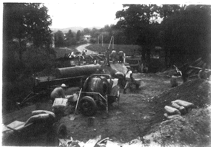
Trwają prace przy budowie nowego mostu w Kończyskach
