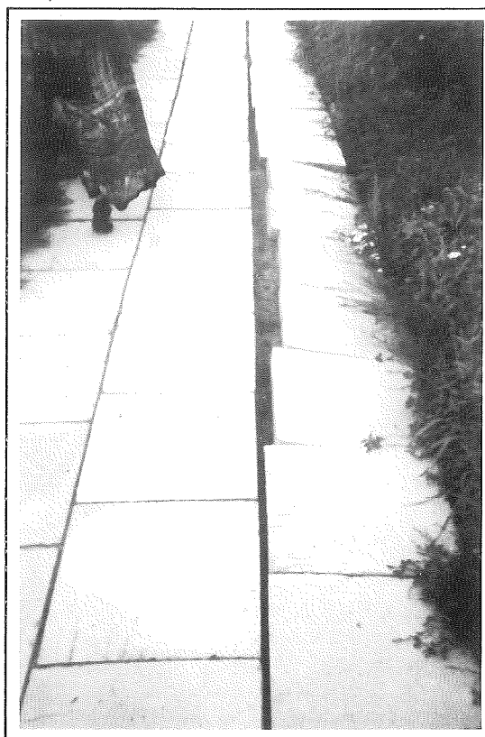
Tak wygląda w 3 miejscach nowo wybudowany chodnik na ul. Jana III Sobieskiego. Obrzeża już w fosie, w dół jadą płytki
