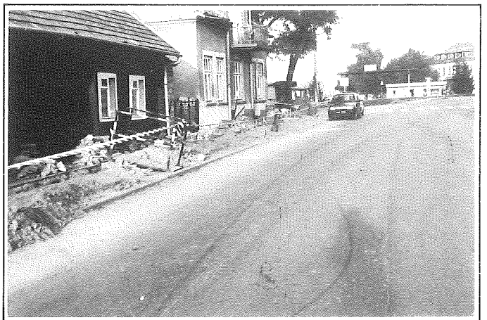
Roboty przy okablowaniu sieci elektrycznej posuwają się jak widzimy w zadowalającym i szybkim tempie.
