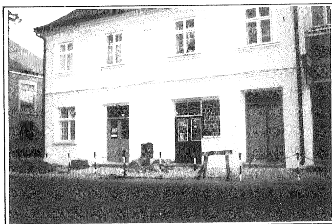
Front odnowionego budynku mienia wsi wygląda już całkiem inaczej.
