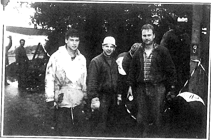
Pracownicy firmy Eltar podczas prac kablowania Zakliczyna.
