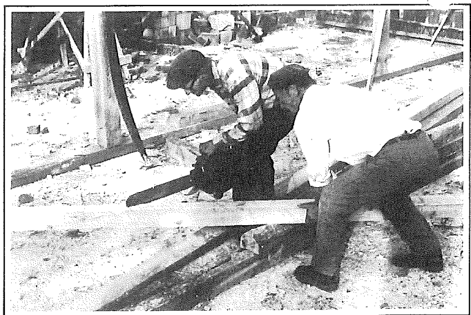
Prace przy dachu na segmencie B pracują Pan Adolf Potok oraz majster od ciesielki.
