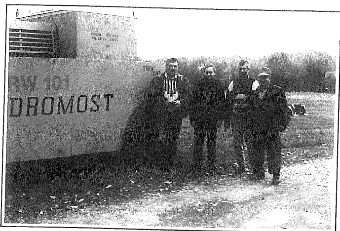
Pracownicy firmy Dromost wykonujący prace przy dywaniku asfaltowym.
