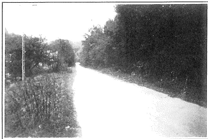
Zupełnie inaczej wygląda przejazd w Rudzie Kameralnej po wycięciu tarasujących drogę krzaków i gałęzi.
