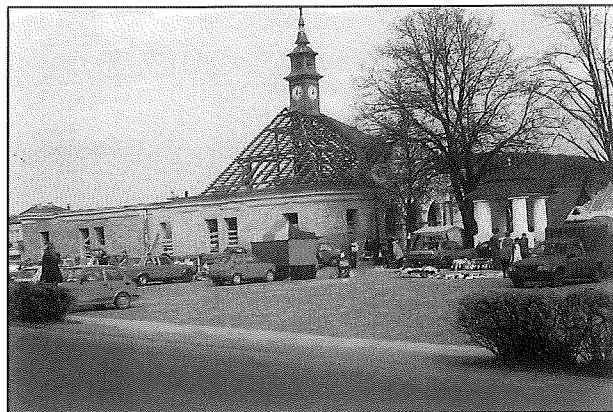
Ratusz w rozbiórce.
