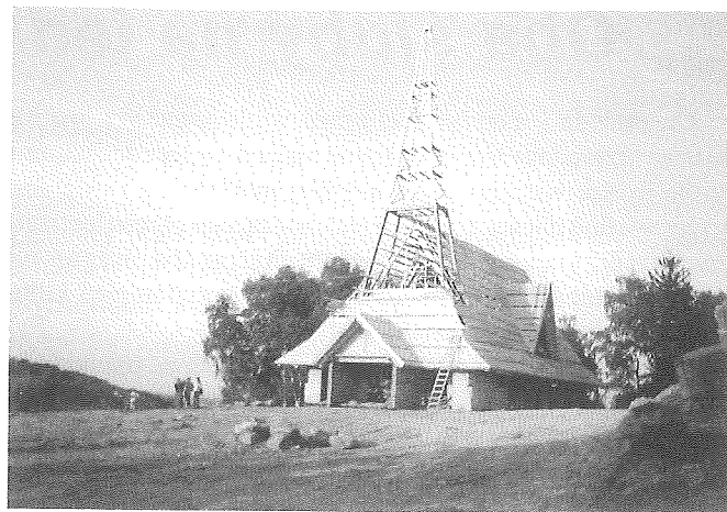
Jamna - nowy kościół w budowie.
