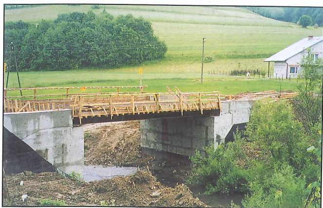
Na moście w Bieśniku prace postępują w zadowalającym tempie.
