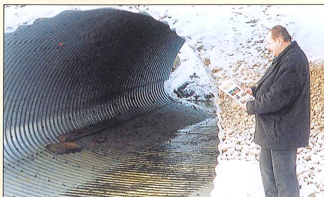
Prace przy przepuszczeniu w Paleńnicy zostały ukończone. Kierownikowi budowy Januszowi Tomaszewskiemu pozostało tylko poczytać Głosiciela.
