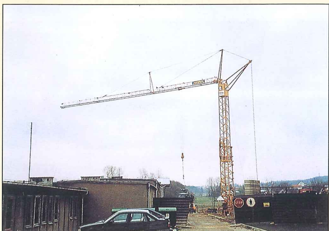
Przy ZSZ rozpoczęły się prace przy budowie szkolnej hali sportowej.
